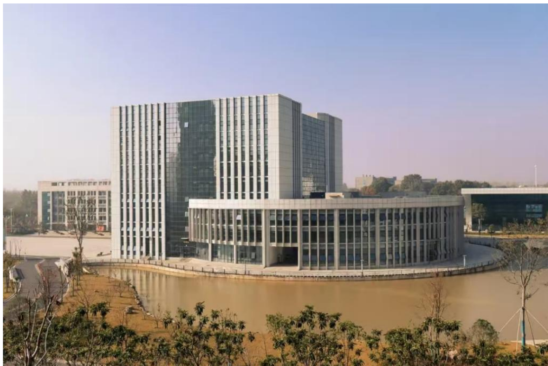
图 4 图书馆和艺体技能实训楼
